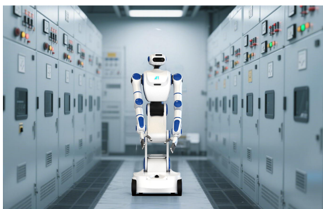
高压电气设备操作
